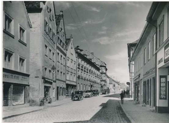
Schmieidstrasse nach Norden (Quelle: Dr. Heberlein)
