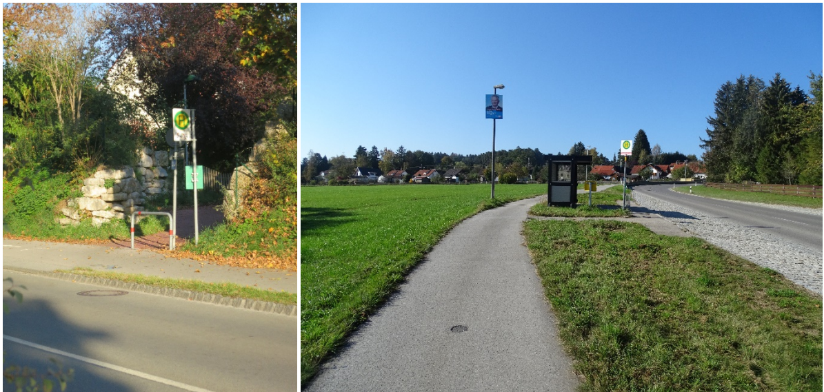
Abb. 37: Führung der RVA durch den Warte- und Zustiegsbereich (links); Trennung der Konfliktbereiche (rechts)
