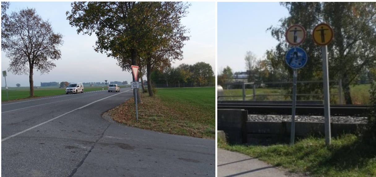
Abb. 23: Falsch ausgerichtetes/verdrehtes Zusatzzeichen (links); verschmutztes Verkehrszeichen
