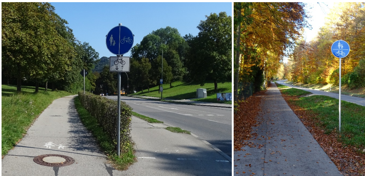
Abb. 26: Nicht mehr gültiges Zusatzzeichen 1000-33 zur Kennzeichnung von Zweirichtungsradwegen (links) und fehlende Kennzeichnung (rechts)
