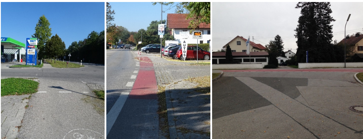
Abb. 31: Fehlende bzw. missverständliche Furtmarkierung (links); erneuerungsbedürftige Furt (mitte); optische Wirkung einer Furt an einem Knoten (rechts)
