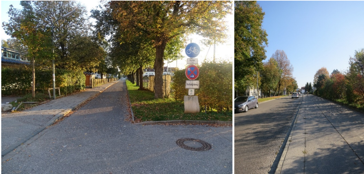
Abb. 34: taktile erfassbare Trennung zum Gehweg (links); unzureichende Trennung zum Gehweg (rechts)
