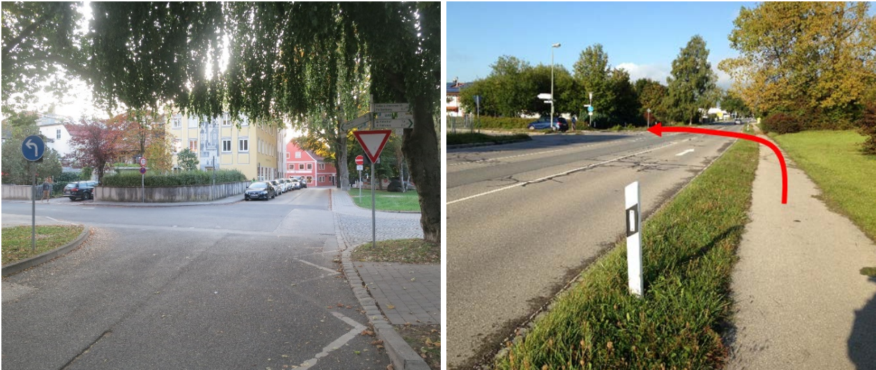
Abb. 28: Fehlende Abbiegebeziehungen an Netzknoten aufgrund mangelhafter Beschilderung (links) und baulicher Mängel (rechts)
