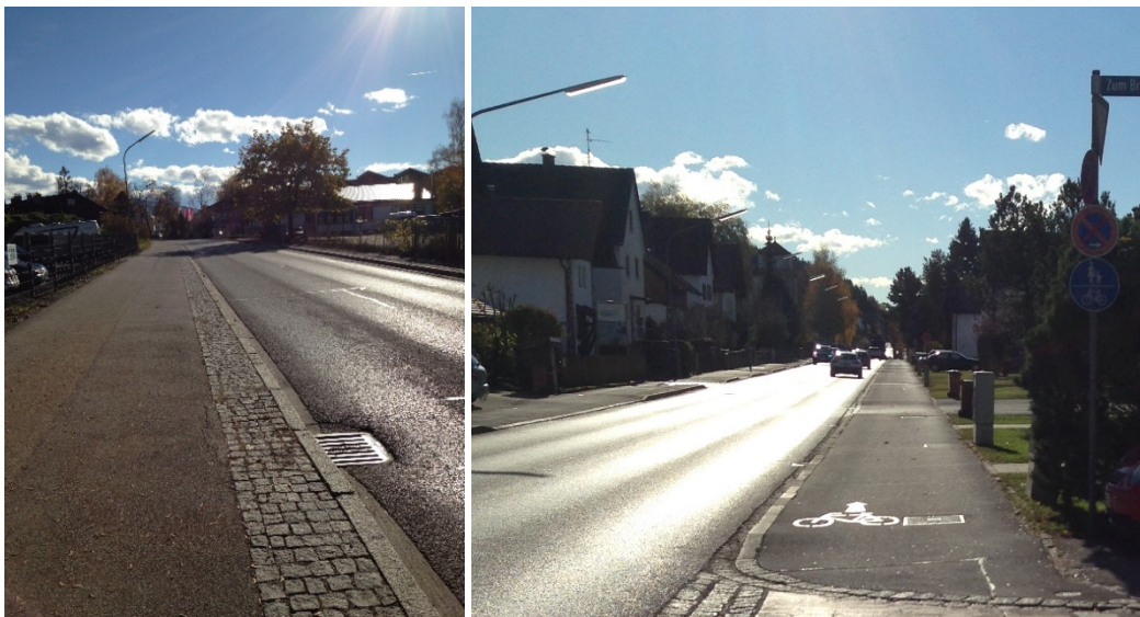
Abb. 35: Baulicher sicherheitstrennstreifen zur Fahrbahn (links) Fehlender bzw. nicht markierter Sicherheitsraum zur Fahrbahn (rechts);
