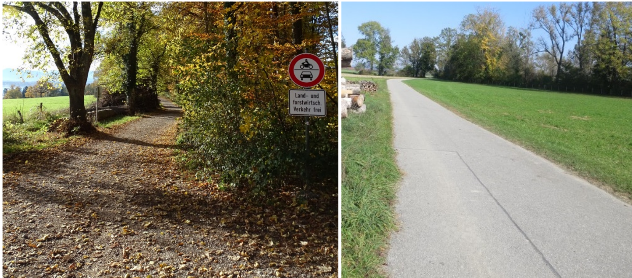
Abb. 22: Netzelemente mit nicht ausreichender Oberflächenbeschaffenheit (links) und mit idealer Oberflächenbefestigung (rechts)
