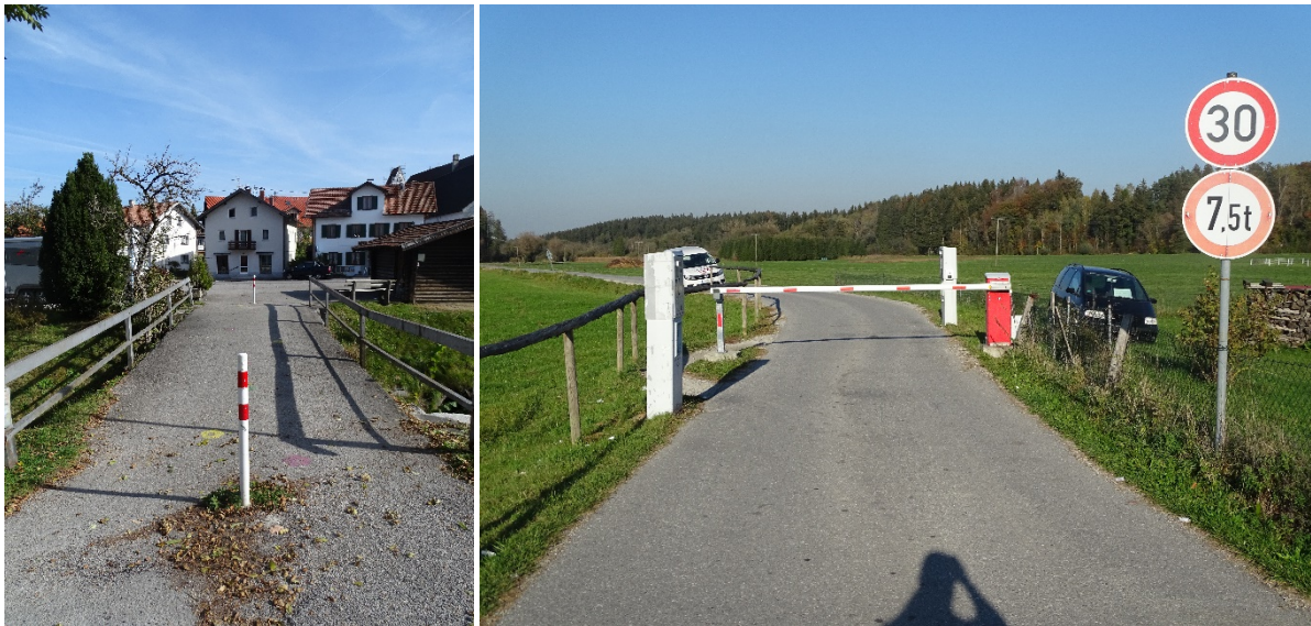
Abb. 36: Sicherheitsrisiko durch Poller und Behinderung durch Schranke
