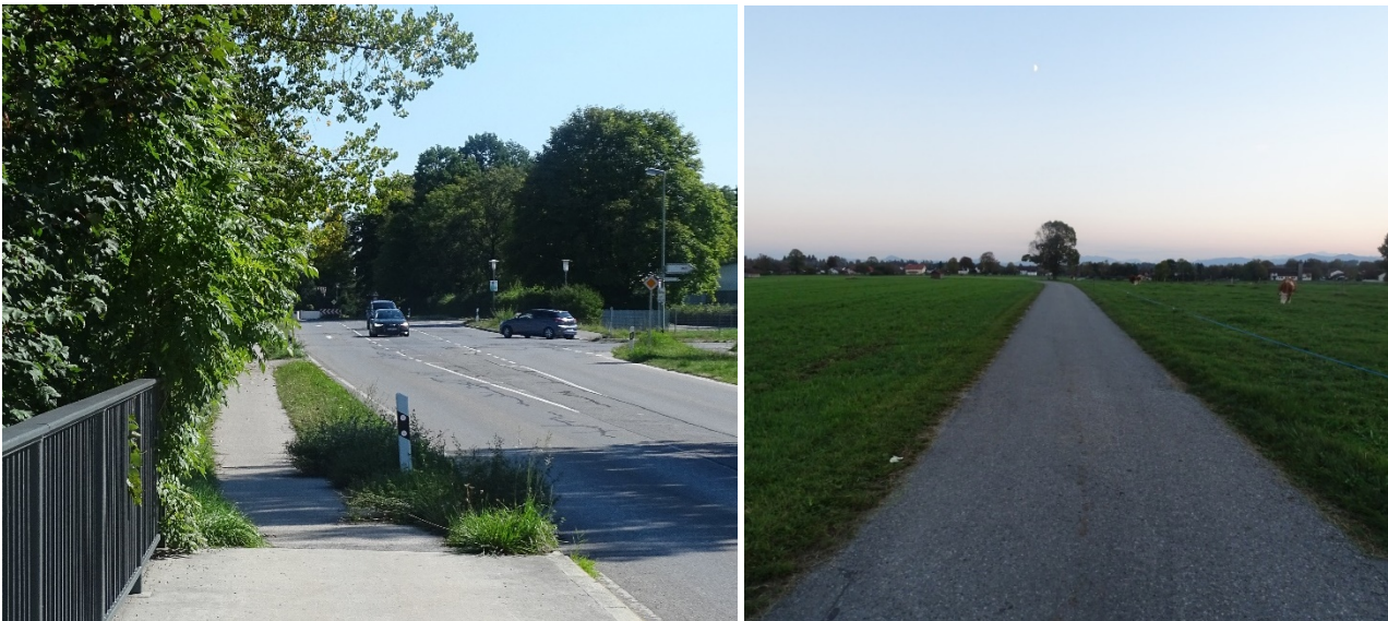
Abb. 21: Zu schmal dimensionierter Radweg (links); Radwegebreite entspricht den Qualitätskriterien
