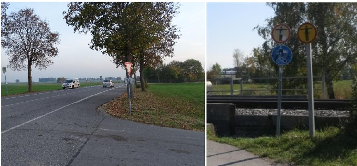
*Abb. 23: Falsch ausgerichtetes/verdrehtes Zusatzzeichen (links); verschmutztes Verkehrszeichen*
