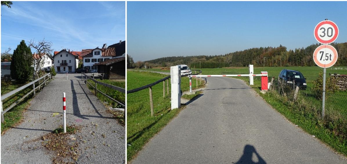
*Abb. 36: Sicherheitsrisiko durch Poller und Behinderung durch Schranke*
