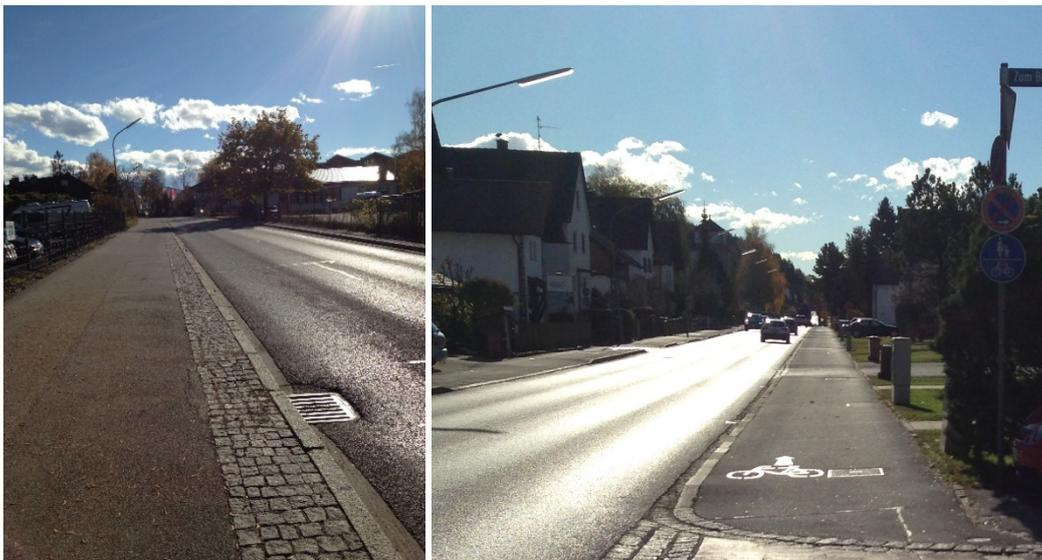
Abb. 35: Baulicher sicherheitstrennstreifen zur Fahrbahn (links)
