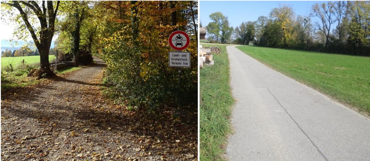
*Abb. 22: Netzelemente mit nicht ausreichender Oberflächenbeschaffenheit (links) und mit idealer Oberflächenbefestigung (rechts)*
