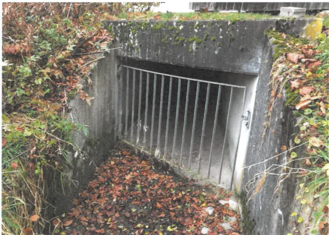
Abbildung 3-1: Einleitungsstelle der Mischwasserbehandlung
