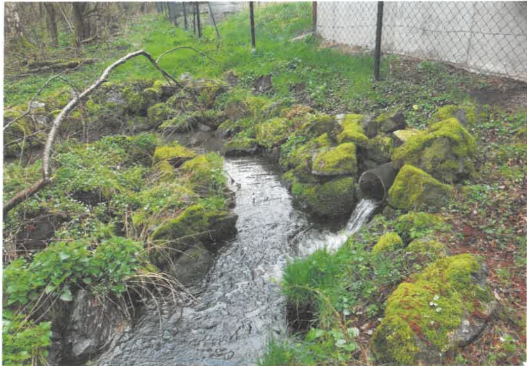
Abbildung 3-2: Einleitungsstelle der Kläranlage
