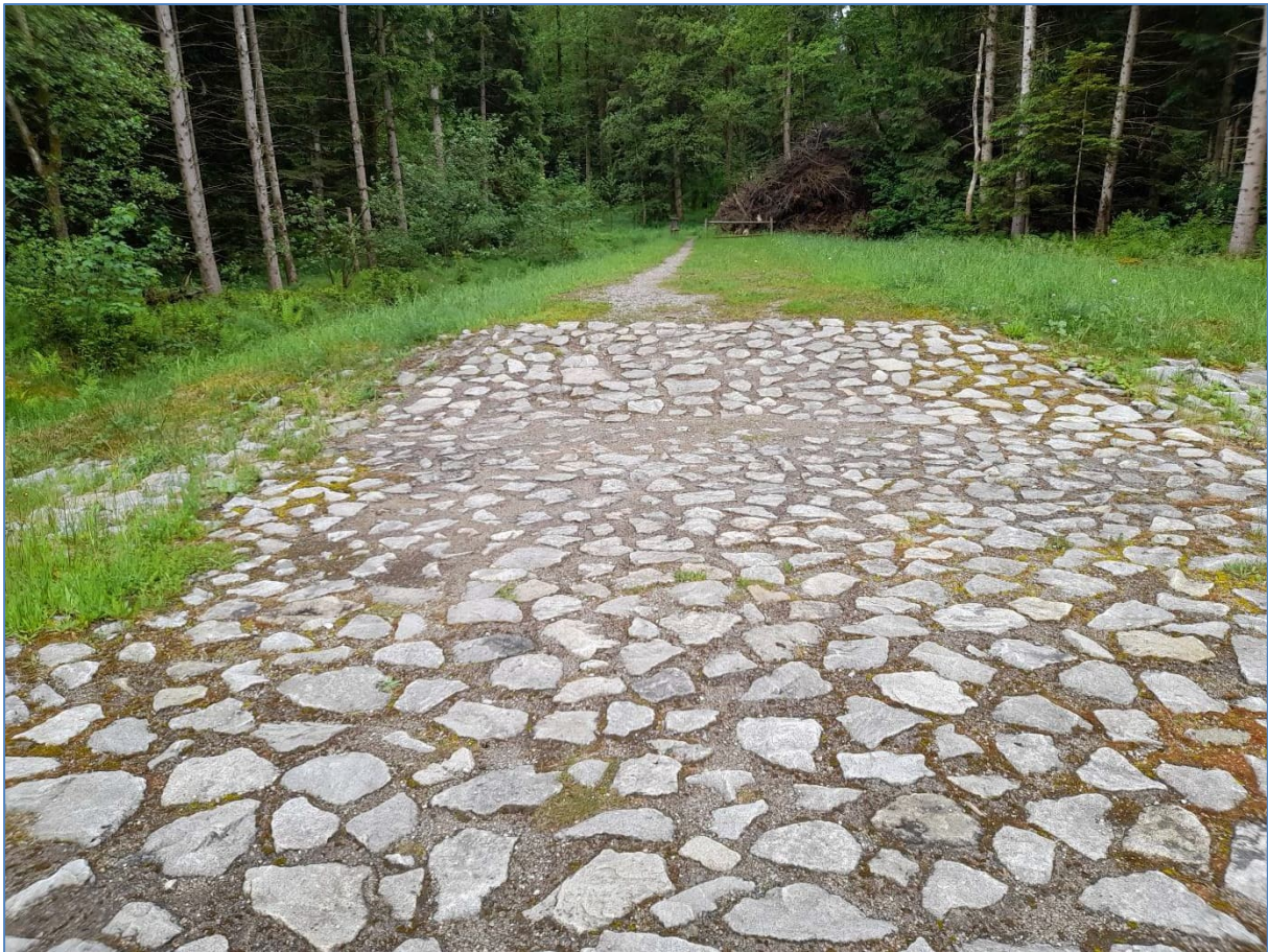
Abbildung 9: Notüberlauf RRB mit Blick nach Süden (rechts ist Becken III des RRB).
