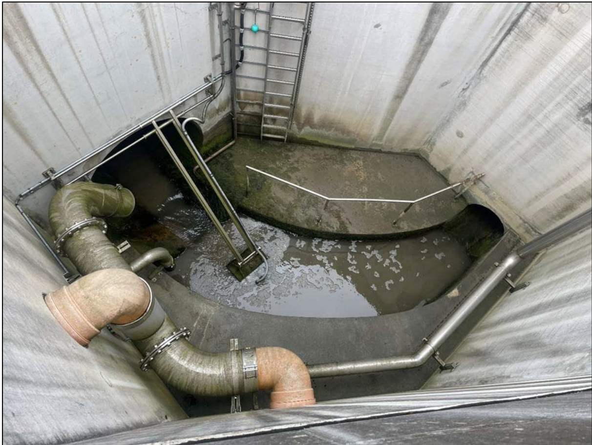
Abbildung 2: Analyseschacht (Schacht R41/11)
