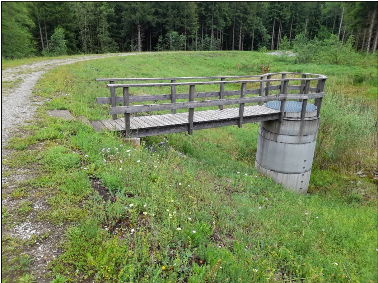
Abbildung 5: Drosselablaufschacht 2 (DS40/3) im Becken III
