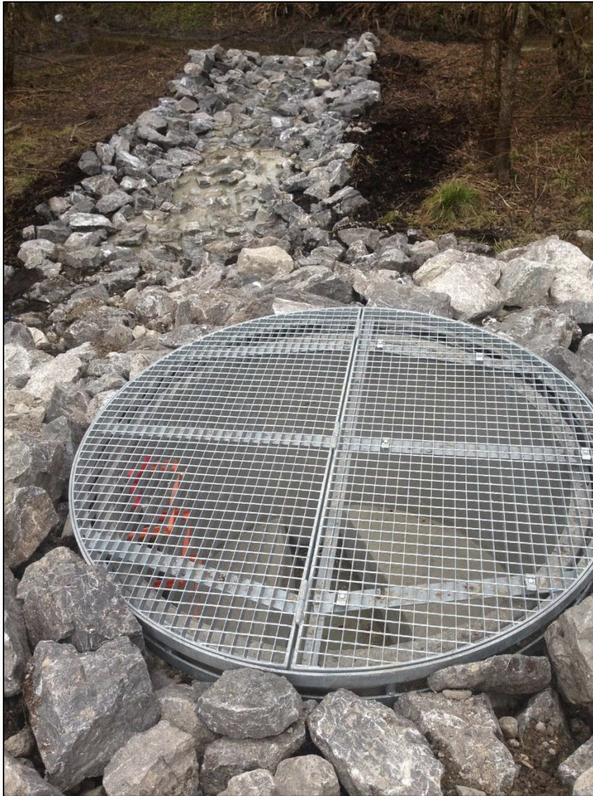
Abbildung 8: Bestehende Zulaufeinrichtung (Quelltopf) zum RRB mit Raubbettmulde
