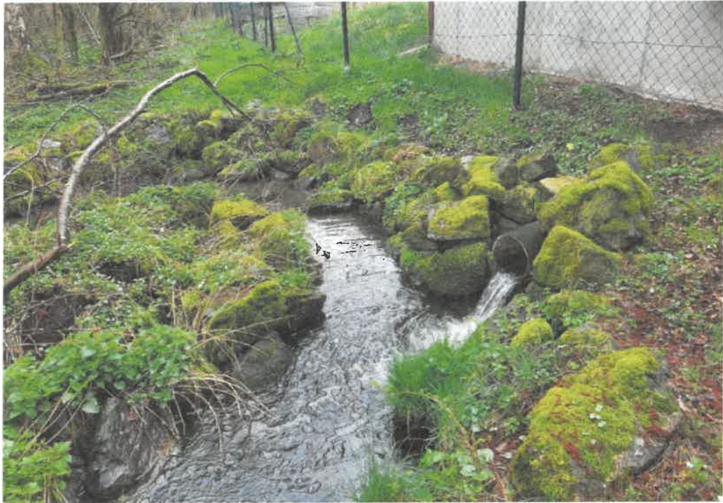
Abbildung 3-2: Einleitungsstelle der Kläranlage
