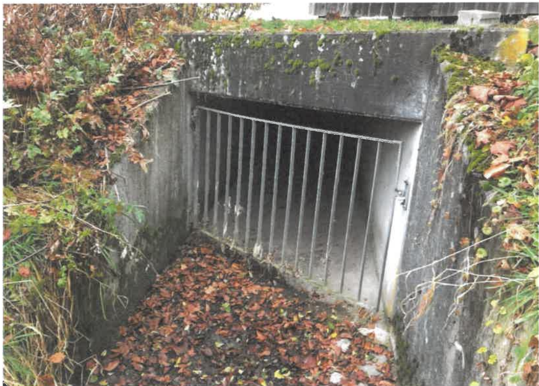
Abbildung 3-1: Einleitungsstelle der Mischwasserbehandlung
